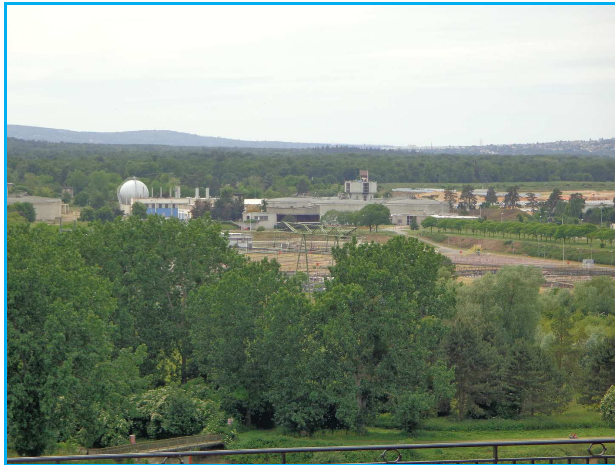
Figure 70 : Exemple de vue plongeante sur l'UPEI
