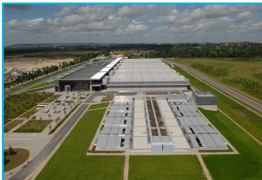
Figure 125 : Vue aérienne des installations de nitrification-dénitrification
