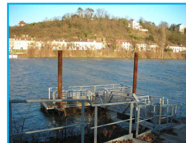
Figure 54 : Bac de traversée de la Seine
