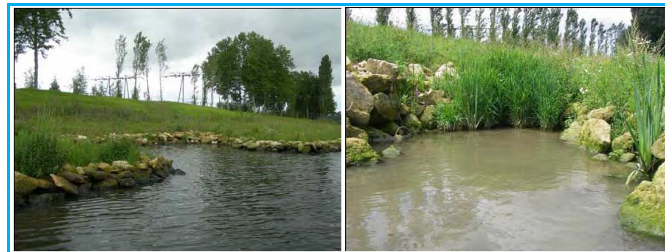
Figure 52: Frayères au droit de l'usine Seine Aval
