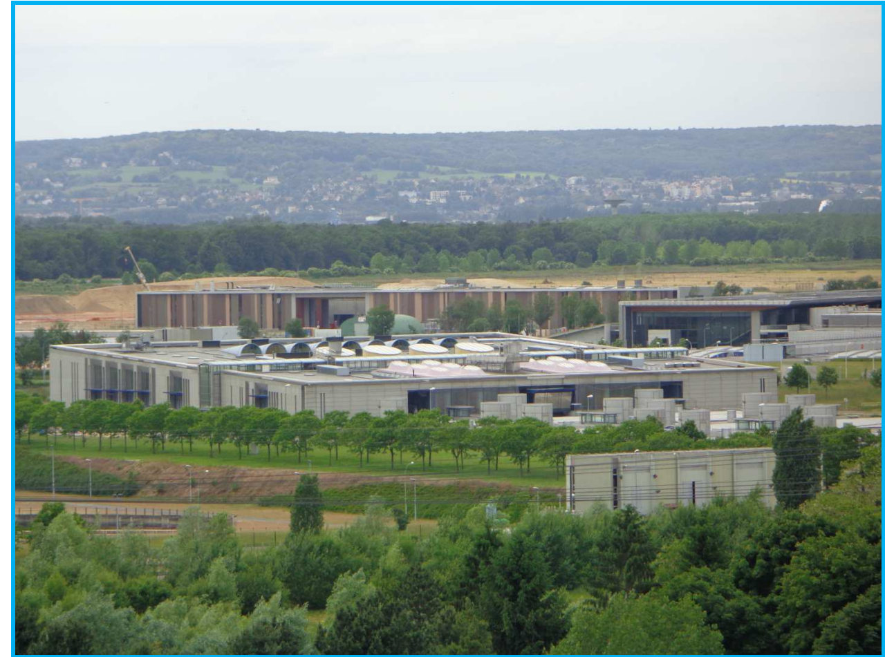
Figure 74 : La station vue depuis La Frette
